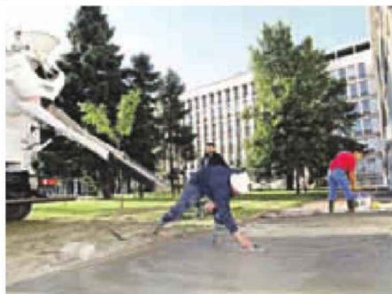
UMIVANJE: Betoniranje platoa ispred Palate „Srbija“
